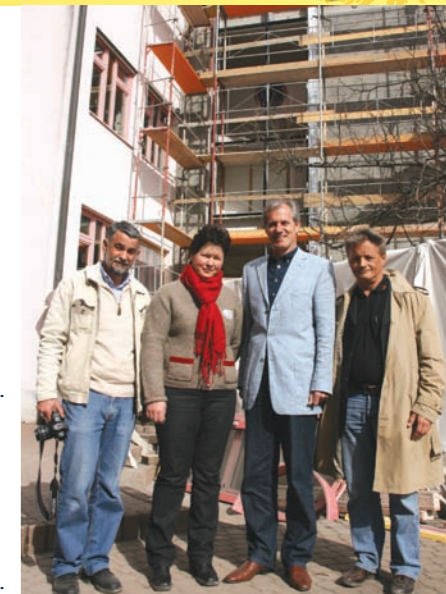
Die thermisch generalsanierte Schule in Schiefing, ebenfalls unterstützt aus dem Konjunkturpaket.
